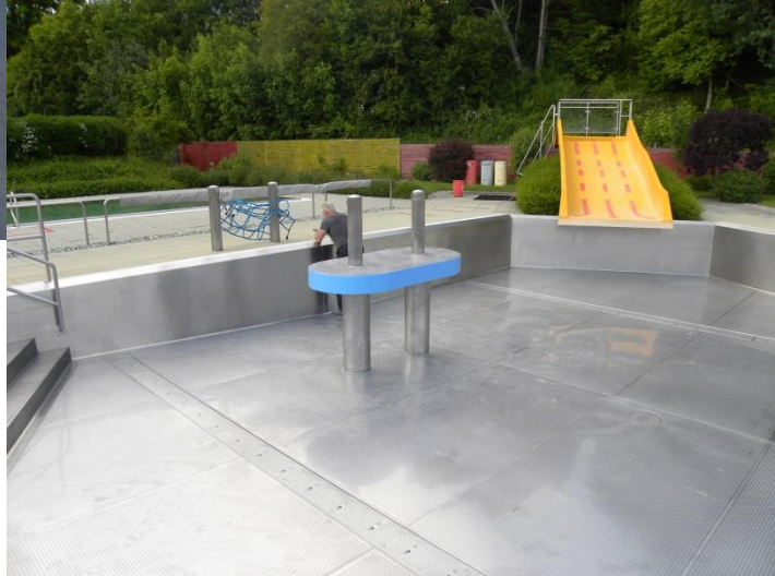
Die Insel im Erlebnisbecken wurde mit einer rutschfesten Folie überzogen
